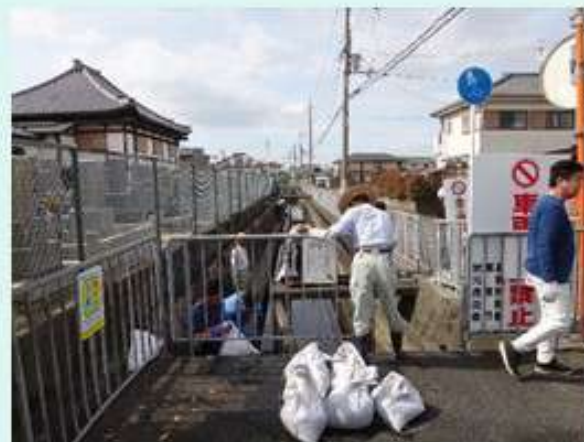
柱本集落水路清掃 (令和 元年 5月19日実施)
